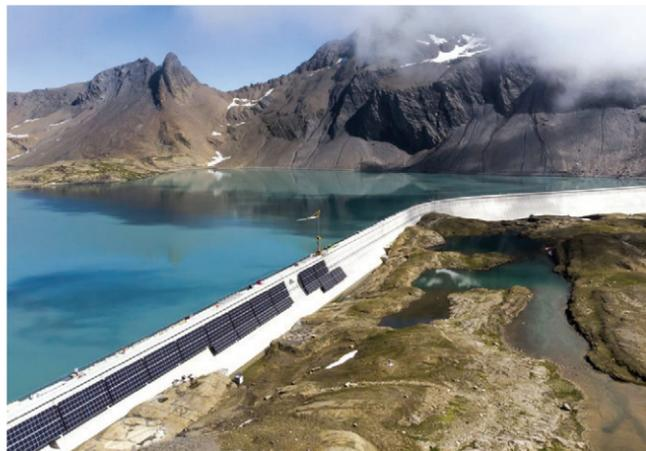
La centrale photovoltaïque sur le mur du barrage de Muttssee, à 2500 m d'altitude dans le canton de Glaris, disposera d'une puissance de 2,2 mégawatts.
