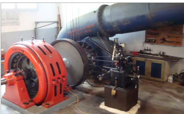
Visite de la petite usine électrique de Richelien: la turbine Francis 1945 des Ateliers des Charmilles Genève
