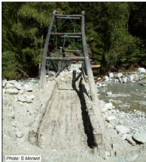
Fig. 6 – Les matériaux transportés par la lave torrentielle du Durmand (volume de 35'000 m<sup>3</sup>) le 25 juillet 2006 à 19h30 ont obstrué le cours d'eau de la Dranse à l'endroit où une passerelle la franchit. A l'aval, la lave torrentielle a arraché le pont ferroviaire et les rails du train, faisant également dérailler le train qui s'apprêtait à franchir le pont.
